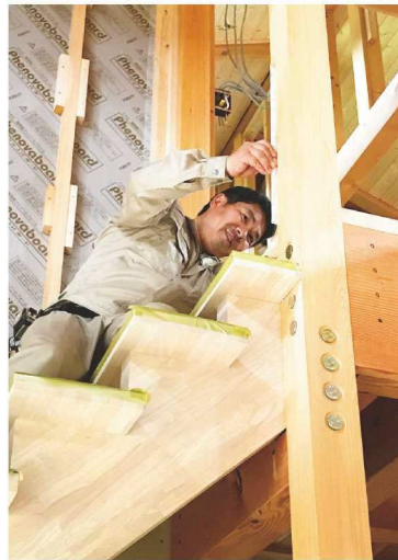
しっかりとした木造施工
