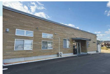
移転した山口営業所の外観
