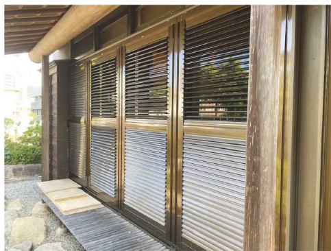
可動ルーバー式の雨戸を施工した様子
