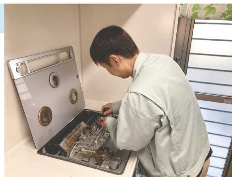
ガスコンロ修理の様子
