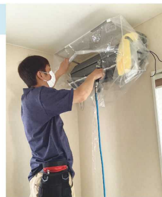
エアコンクリーニング作業の様子
