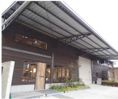
リノベーションの際に残した 工場の大きな庇を支える三角形のトラス梁
