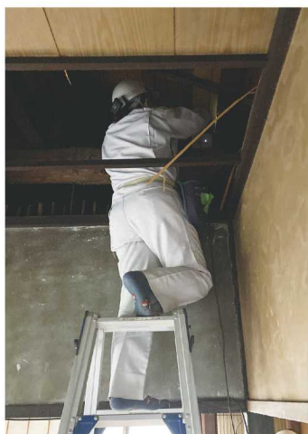
小屋裏の調査と耐震補強
